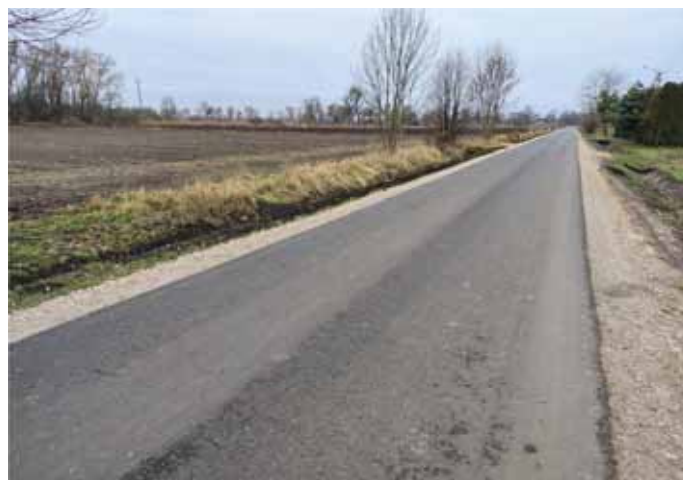
Droga powiatowa nr 1513 w Osinach
