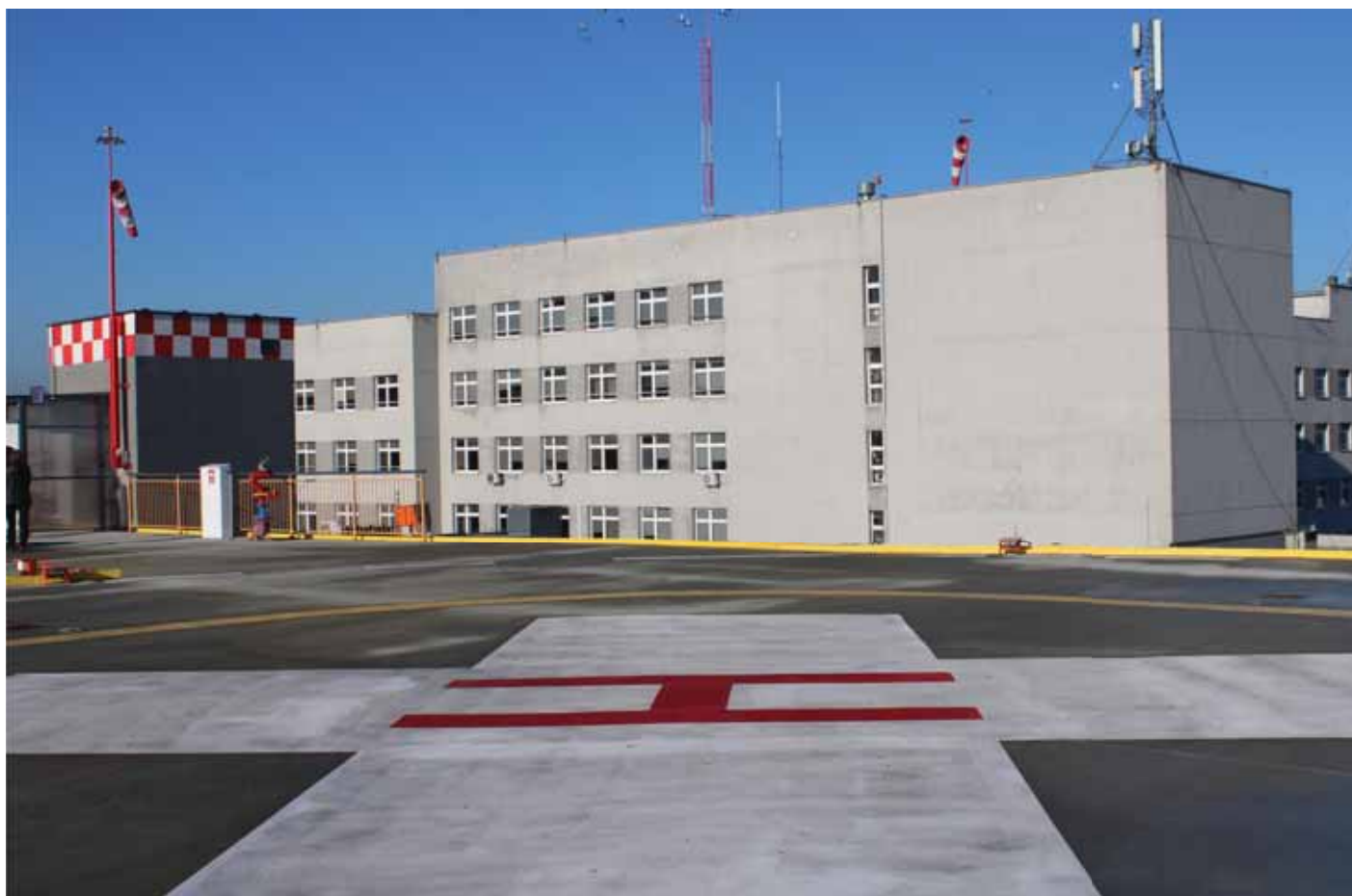
Płyta lądowiska dla helikopterów w Szpitalu Zachodnim
